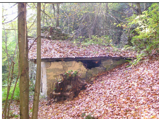
Facciata Nord / Est
