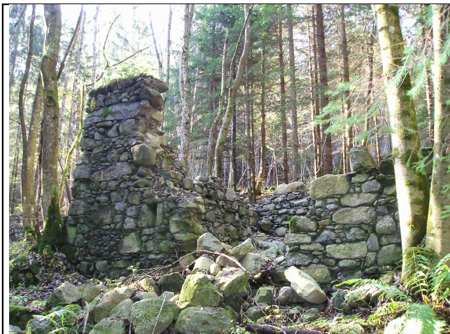
Facciata Nord / Est
