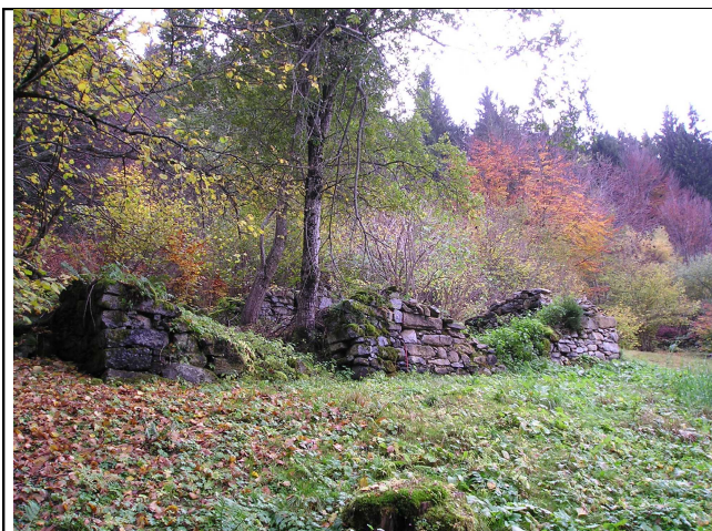
Facciata Nord / Est
