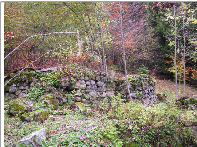
Facciata Nord / Est
