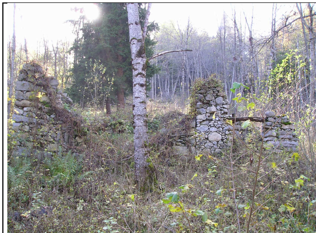
Facciata Nord / Est
