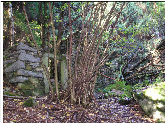
Facciata Nord / Est
