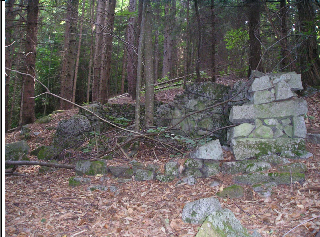
Facciata Nord / Est
