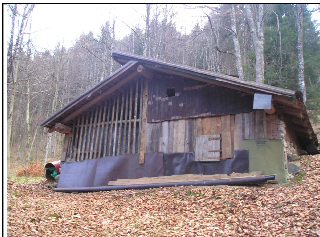
Facciata Nord / Est
