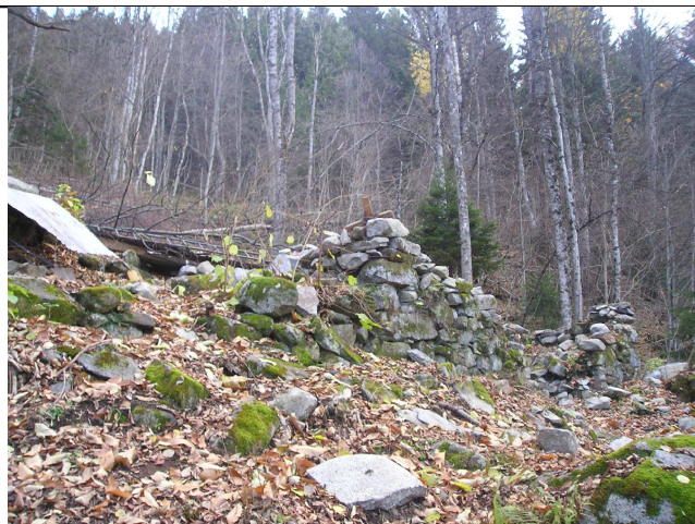
Facciata Nord / Est
