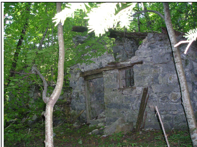
Facciata Nord / Est
