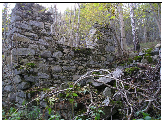
Facciata Nord / Est
