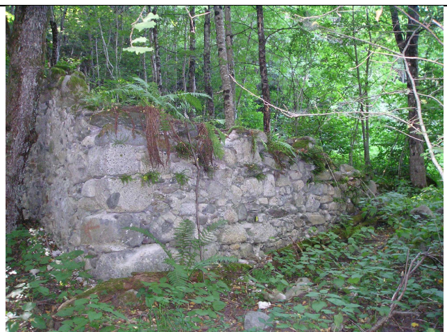
Facciata Nord / Est
